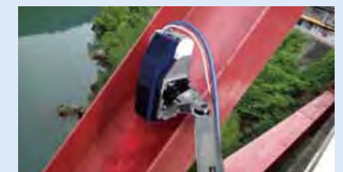
橋梁のメンテナンス
